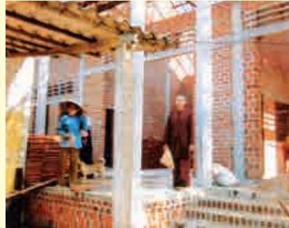
Ngôi chánh điện đang trùng tu đang dở
