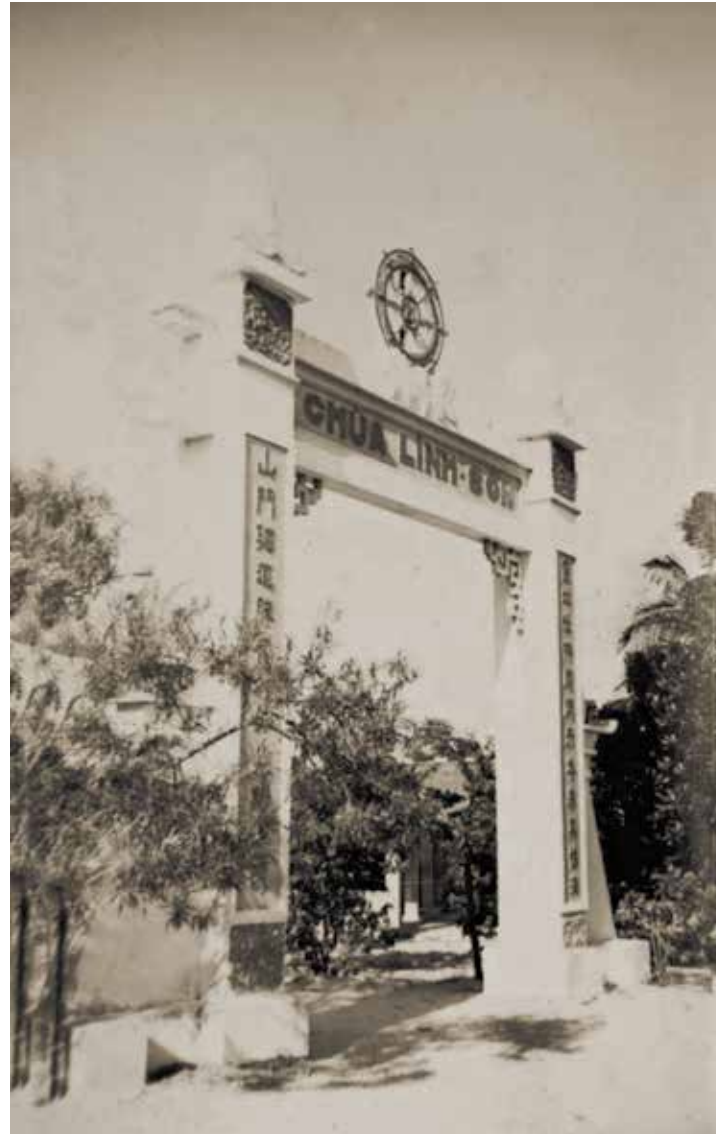
Cổng chào tổ đình Linh Sơn, xây dựng năm 1960 trên 2 trụ gỗ cũ làm ranh giới phía Nam cho diện tích đất chùa
