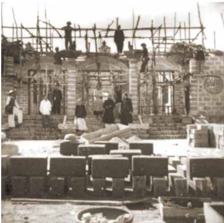
Năm 1954, hòa thượng Tịch Tràng với công trình xây dựng chánh điện trên nền móng đá san hô đặt sẵn của bổ tát Quảng Đức
