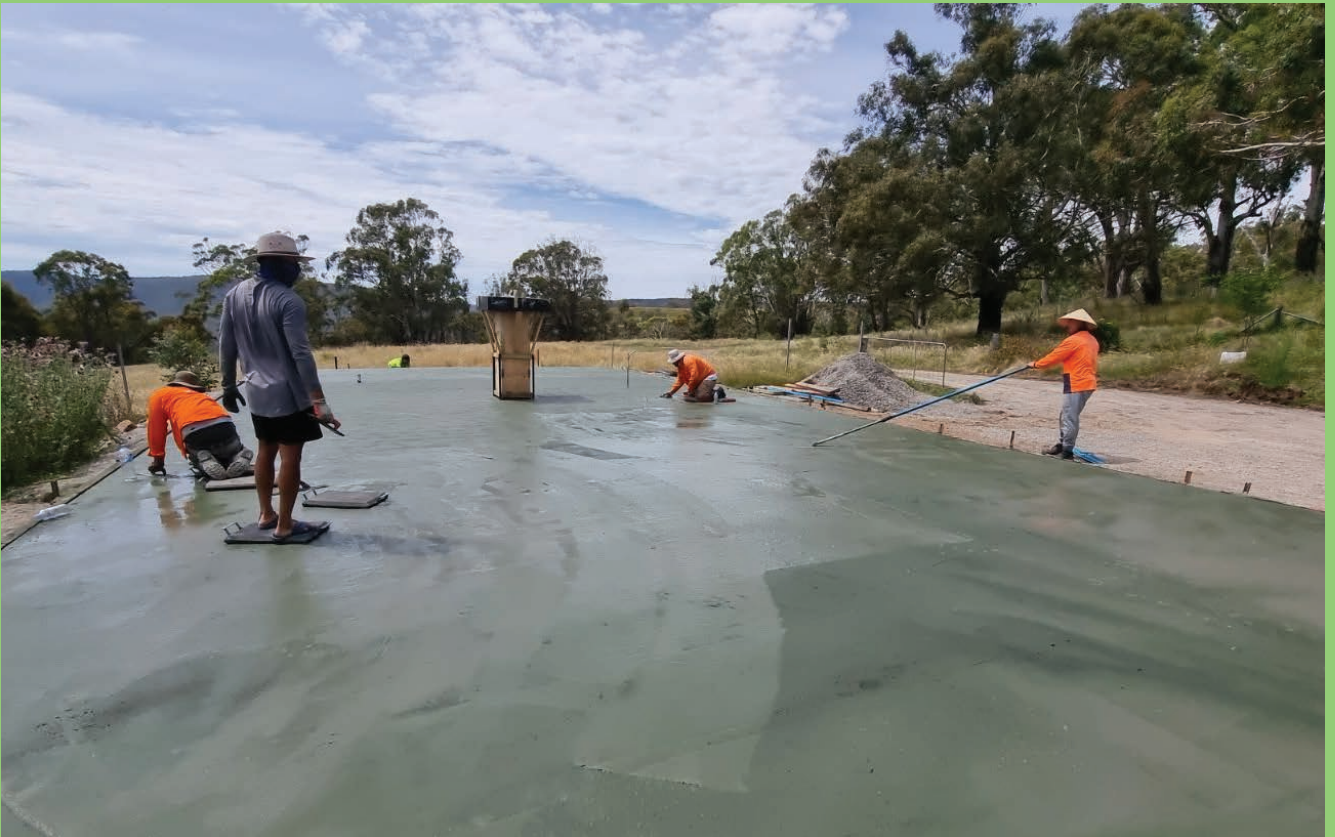
Phật tử công quả đổ concrete để xây dựng Phật Đài Quan Âm Lộ Thiên
