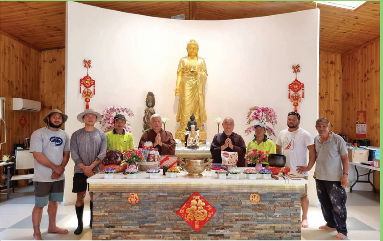
Phật tử công quả đổ concrete để xây dựng Phật Đài Quan Âm Lộ Thiên
