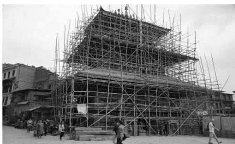
Bhaktapur Durbar Square (Đang trùng tu)
